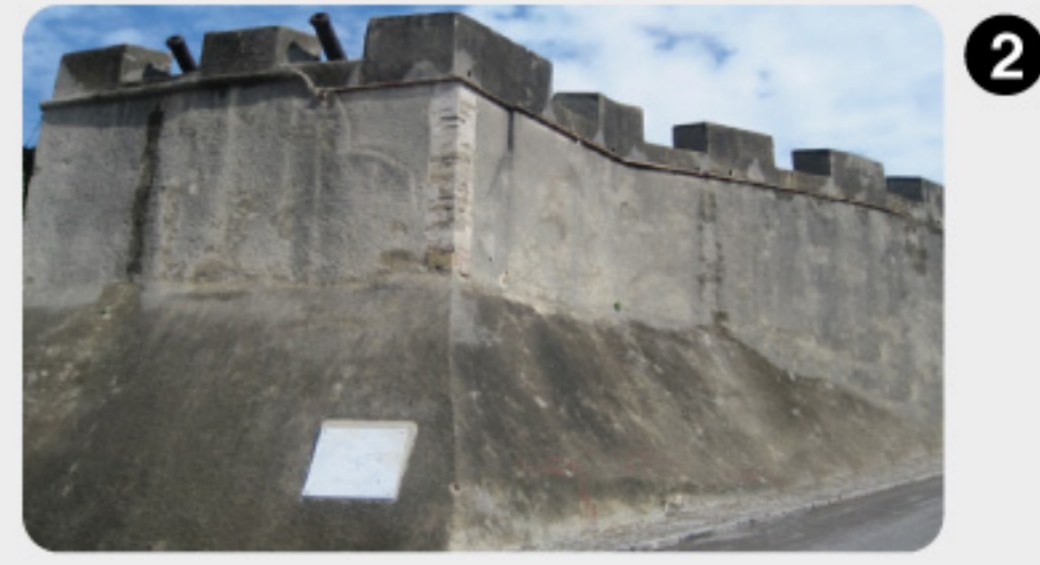
برج القصبة Borj Al Kasba
